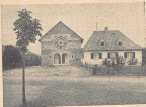
Bild oben: Rohbau der Kirche u. Pfarrhaus.
